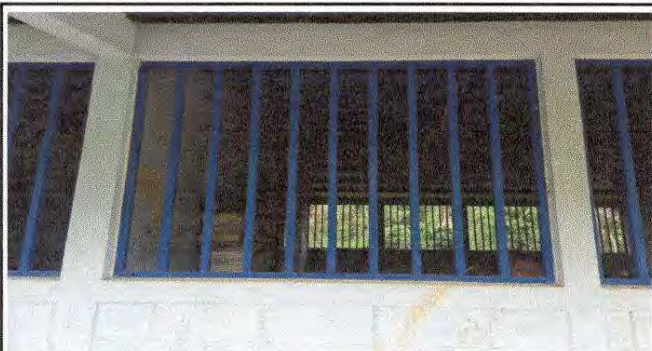
Foto 5: Mantenimiento a balcones de metal
