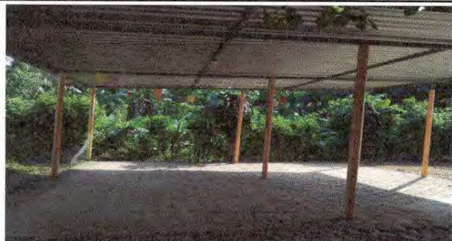
Foto 11: Reparación de planchas de concreto de patio
