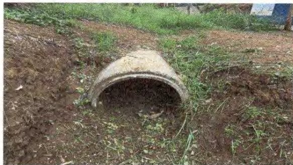
Foto 9: Reparación de cuneta de Concreto
