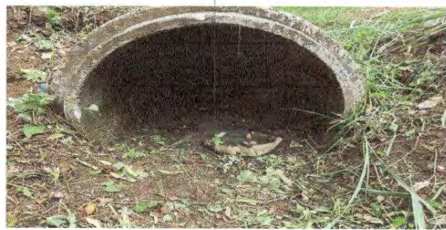
Foto 10: Reparación de cuneta de Concreto
