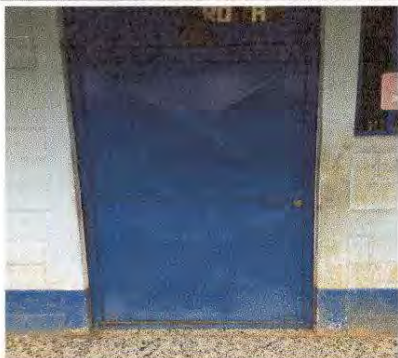
Foto1: Mantenimiento a estructura (lijado, cambio de tubo, cepillado, sujeciones, aplicación de pintura)
