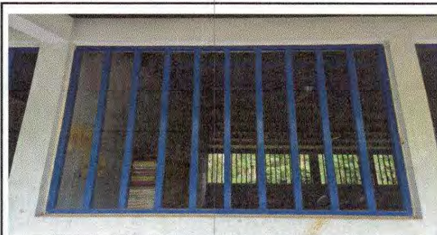
Foto 6: Mantenimiento a balcones de metal
