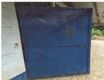
Foto 3: Mantenimiento a estructura (lijado, cambio de tubo, cepillado, sujeciones, aplicación de pintura)
