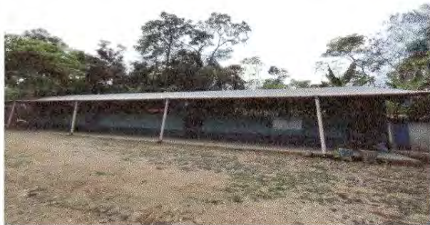
Foto7: Pintura en muros exteriores e interiores
