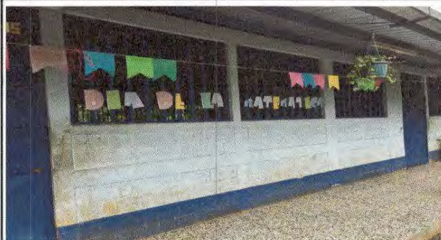
Foto 4: Mantenimiento a balcones de metal
