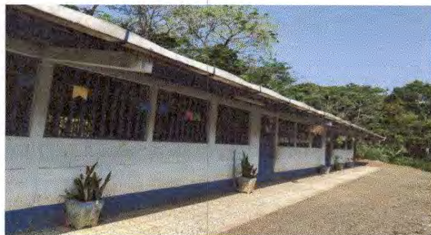
Foto 8: Pintura en muros exteriores e interiores
