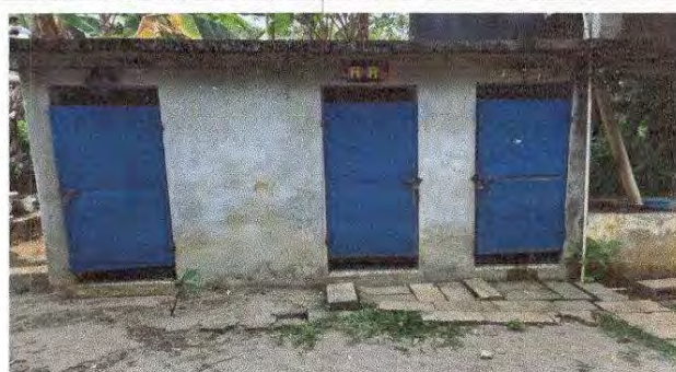
Foto2: Mantenimiento a estructura (lijado, cambio de tubo, cepillado, sujeciones, aplicación de pintura)
